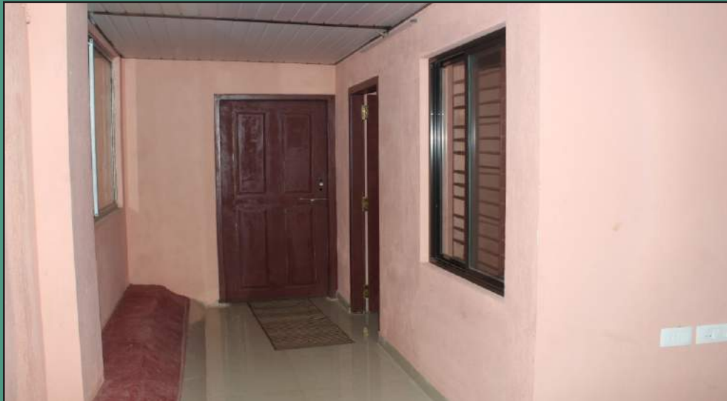
लड़कों के लिए मंगलुरु में निःशुल्क छात्रावास के निर्माण में सहायता
